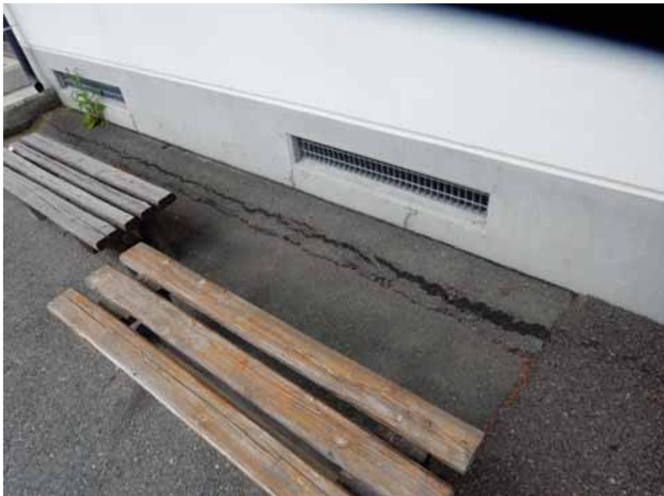
写真 8 地盤沈下した箇所（2015.7.9 撮影）
