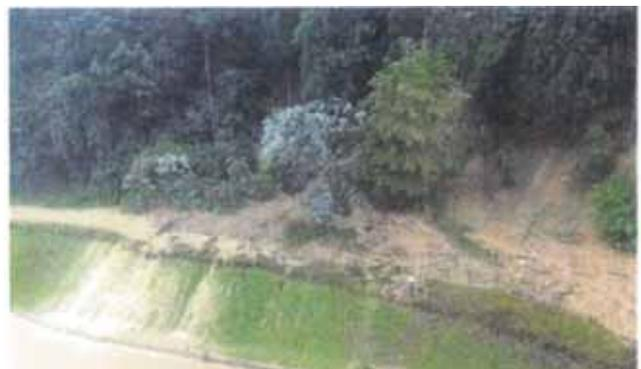
写真 4-2 砂防堰堤周辺の斜面が崩れ道路を塞ぎ土砂が敷地内へ (施設提供)
